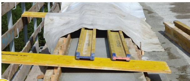
Copertura del manufatto con teli in polimero
