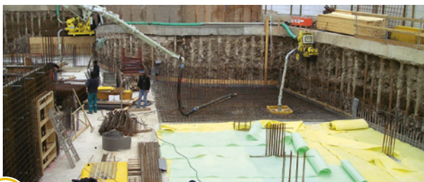
Copertura del manufatto con teli in polimero
